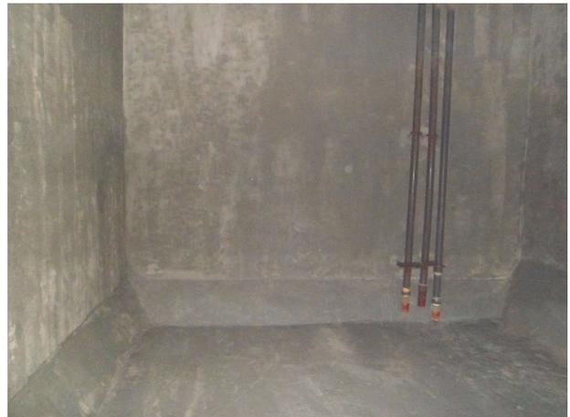
Tras la limpieza aclararlos con agua limpia y procedemos al llenar con agua de la red. Una vez lleno con agua normalizada, se abren los grifos de forma secuencial, de manera ordenada desde el principio hasta el final de la red. Hasta obtener valores de cloro normal de uso
